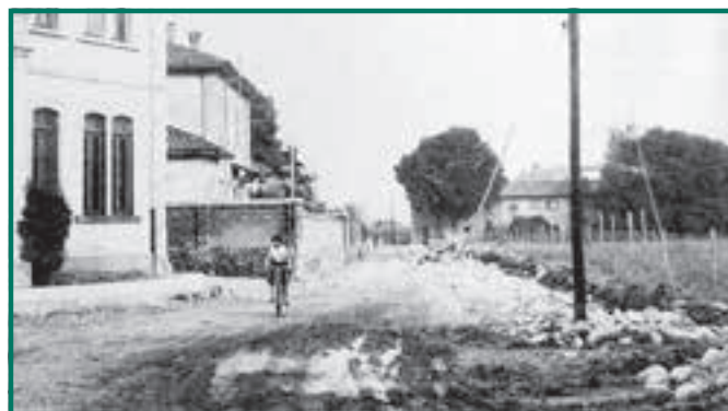
Via s. Margherita appena dopo la demolizione della muraglia.
